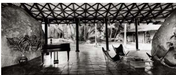
バンガローの居間（竣工当時の様子）
