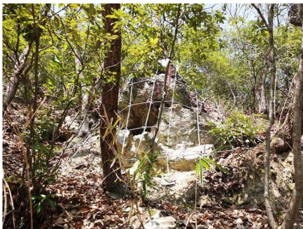
図4：ネットで対策された不安定岩塊
