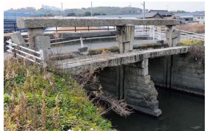
撤去を待つ倉水門
